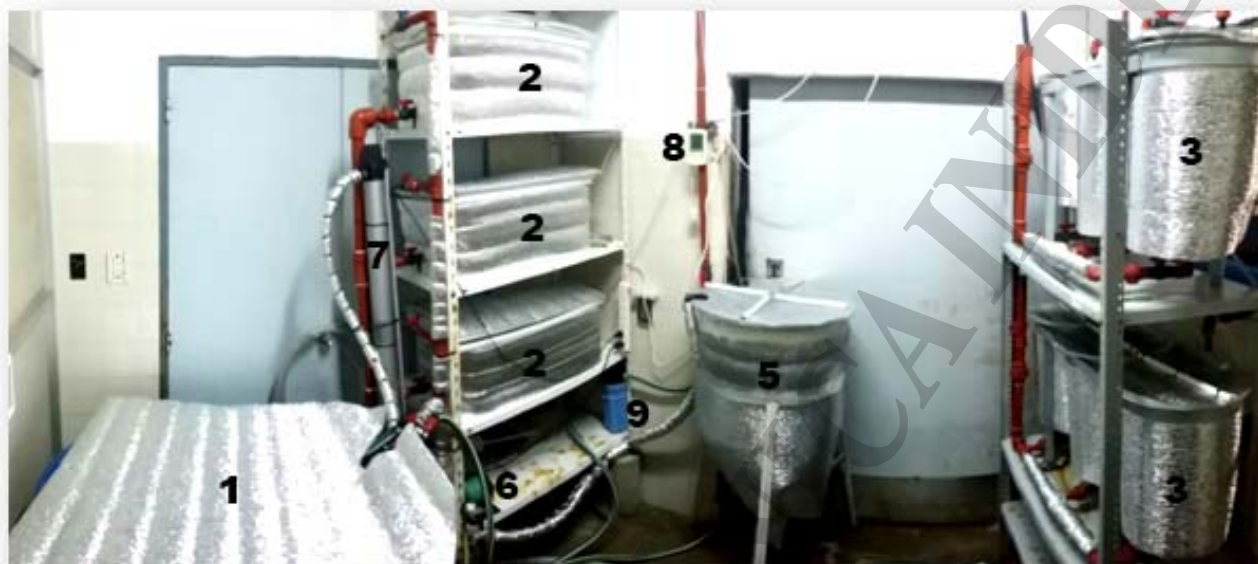
Figura 2. Sistema de recirculación empleado para el desarrollo larval y mantenimiento de ejemplares de centolla ( Lithodes santolla ) en el INIDEP, espacio de 4 m 2 . 1) Filtro biológico, 2) Tanques para hembras ovígeras (bins), 3) Tanques tronco-cónicos (larvarios), 4) Colector de larvas, 5) Equipo enfriador, 6) Bomba, 7) Filtro UV, 8) Termómetro digital, 9) Filtro de partículas.
